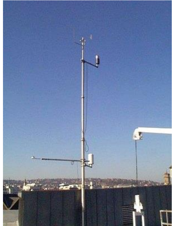
Abbildung 9: Teleskopmast der Messstation Schwabenzentrum Stuttgart (LHS, 2016e).
